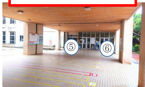
「横側玄関」屋根下ピロティ
