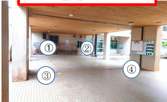
「こども園側」屋根下ピロティ
