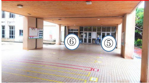
「校舎側」屋根下ピロティ
