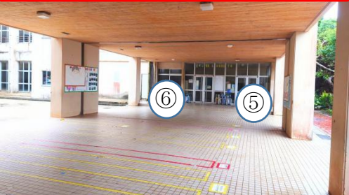
「校舎側」屋根下ピロティ
