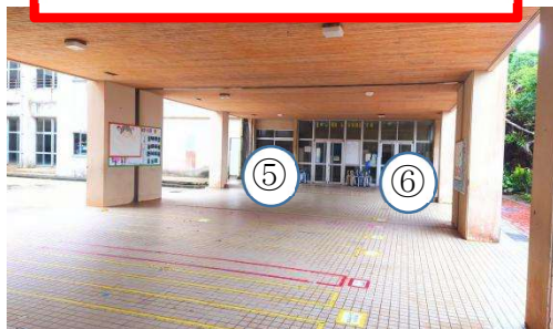
「横側玄関」屋根下ピロティ
